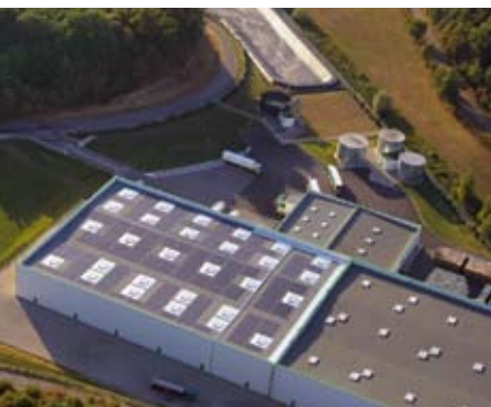
Une des réalisations, suite au Bilan Carbone® : le toit photovoltaïque
