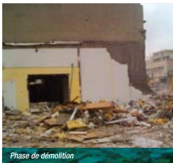
Phase de démolition
