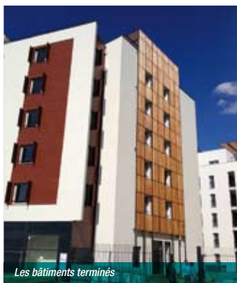
Les bâtiments terminés
