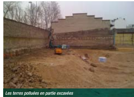
Les terres polluées en partie excavées
