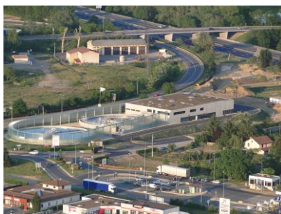
La station d'épuration de Belleville Crédit photo : STEU
